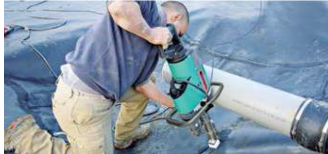
WELDPLAST S6 při montáži na skládce.
