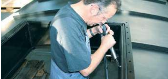
DIODE PID svařování PE nádrže.
