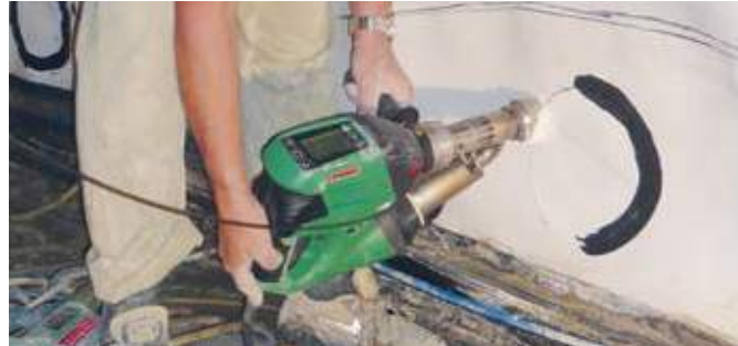
WELDPLAST S2 navařování záplaty v tunelu.
