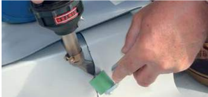
HOT JET S svařuje T-svar na ploché střeše.
