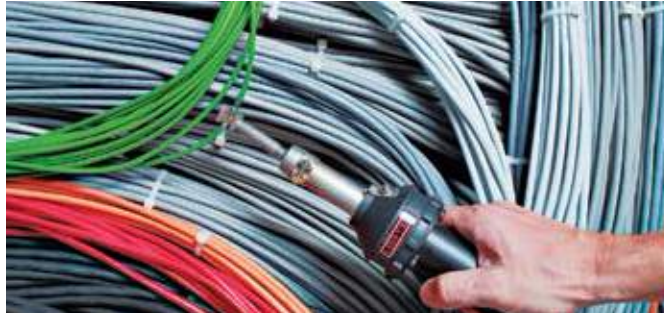
HOT JET S smršťování elektroizolace pomocí děrovaného reflektoru.
