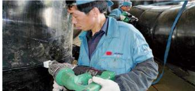
FUSION 2 při výrobě nádrže v Číně.
