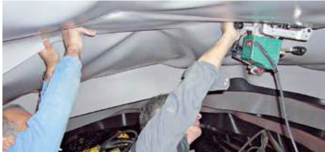
Svařování s přístrojem COMET v tunelu...
